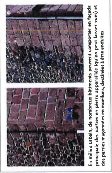
La disparition de l'enduit signifie aussi celle des dispositions architecturales. On donne ainsi un aspect courturé de vieilles cicatrices à ce qui devrait être régulier et lisse (assemblage de moellons sans qualité particulière, arcs de décharge...).
